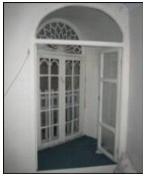
شکل ۱۸ ساخت پنجره مضاعف در خانه بهبودی تبریز.
