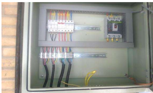
شکل ۶ تابلو AC,DC - جعبه وب - حس گر دما و باد. منبع: نگارنده
