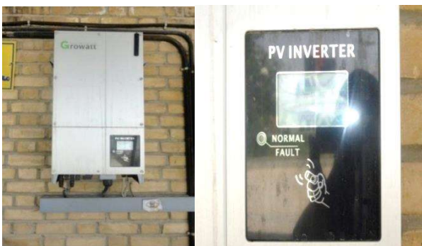
شکل ۵ اینورتر یا میدل الکترونیک قدرت AC/DC. منبع: نگارنده
