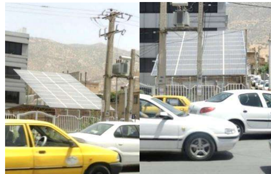
شکل ۳ آرایه‌های فتوولتائیک نصب‌شده در پارکینگ شرکت توزیع برق استان ایلام. منبع: نگارنده
