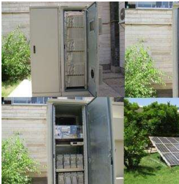
شکل ۴) پیاده سازی سیستم Off-Grid یک سایت BTS در کارخانجات مخابراتی ایران
