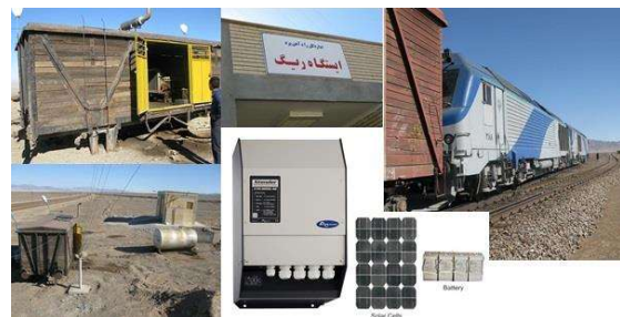
شکل ۸) ایستگاه راه‌آهن با ژنراتور دیزلی که قرار است برق آن با انرژی خورشیدی تامین شود (اینورتر STUDER قابلیت اتصال به چندین منبع تولید برق، در اینجا خورشیدی و ژنراتور دیزل، را دارد)
