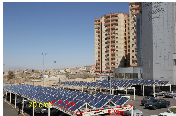
شکل ۲ محوطه ستاد شرکت توزیع برق آذربایجان شرقی
