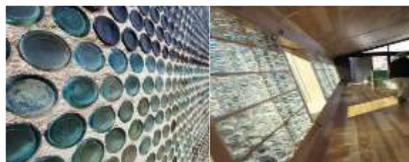
شکل 4 دیوار ترومب، بطری‌های پر از آب [22]
