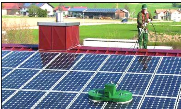
شکل 1 روش تمیزکنندگی دستی همراه با آب [27].
