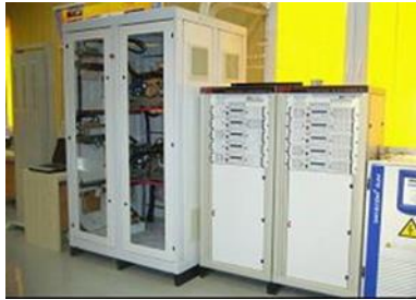
شکل ۹ پیل سوختی ۲۵ کیلووات مورد استفاده در نیروگاه طالقان [۵۵]
