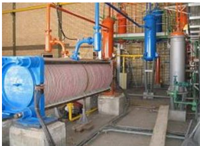
شکل ۱۰ کنترلر ۲۰۰ کیلووات نیروگاه طالقان [۵۵]
