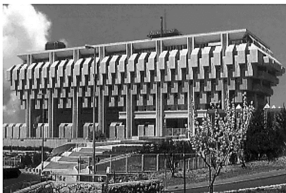
شکل ۲ ساختمان بانک با نماهای خودسایه انداز [۱۶]
