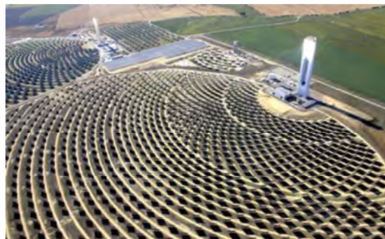
شکل ۵ متمرکز کننده مرکزی [۵]
