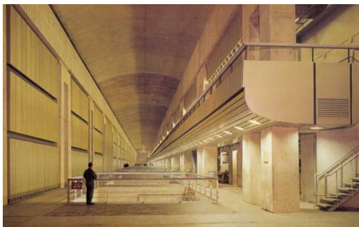
شکل ۱۵ نمای داخلی نیروگاه لارنس
