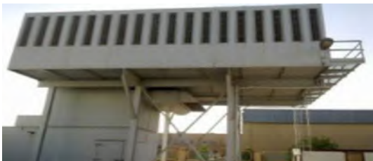
شکل ۳ قسمت سامانه فیلتراسیون در ورودی هوای توربین
