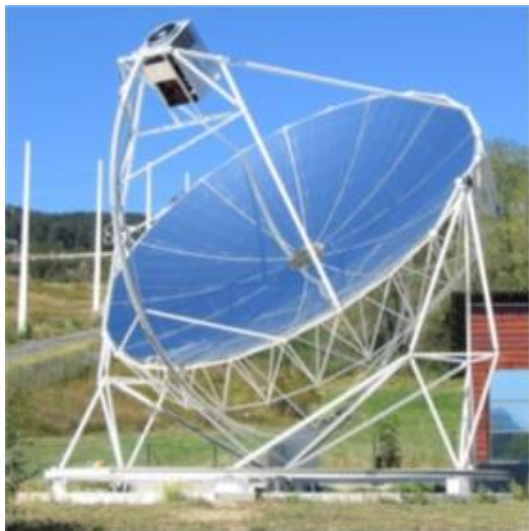
شکل ۱۹ نمایی از یک موتور استرلینگ خورشیدی [۶]
