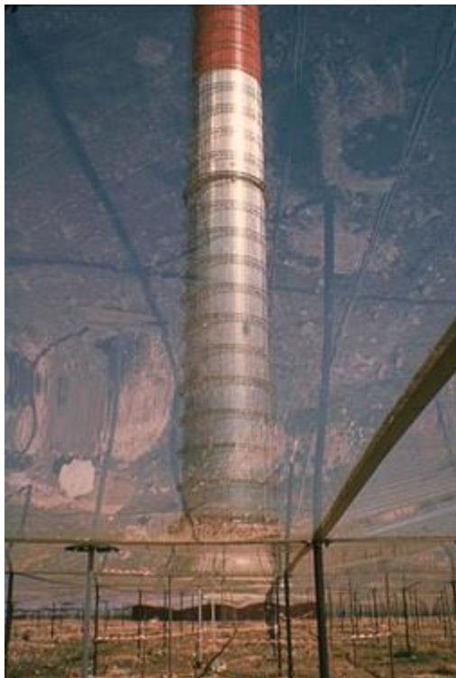
شکل ۲: نمایی از برج و کلکتور جمع‌کننده یک دودکش خورشیدی
