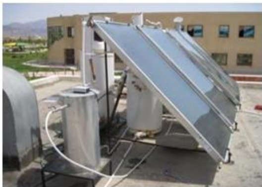
شکل ۱۶ نمایی از یک آبگرمکن خورشیدی با مخازن ذخیره
