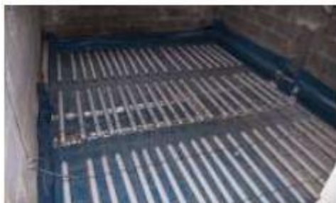
شکل ۱۵ نمونه‌ای از لوله‌های حاوی مواد تغییر فاز دهنده
