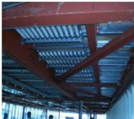
شکل ۲۵ نمای از نحوه نصب مواد تغییر فاز دهنده در سقف کاذب ساختمان [۶]
