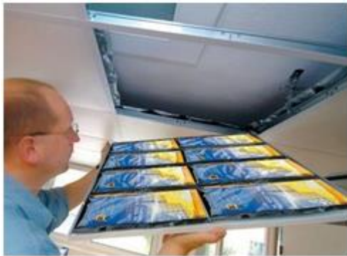
شکل ۲۴ نمای از نحوه نصب مواد تغییر فاز دهنده در سقف کاذب ساختمان [۲]
