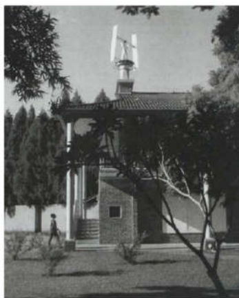
شکل ۸- ترکیب توربین بادی عمود محور با سامانه هواکش در مدرسه ای در زیمباوه [۱۱].
